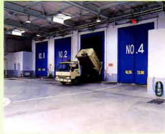
●プラットフォーム 計量されたごみが、プラットフォームのごみ投入扉からごみビットに投入されます。
