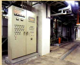
●排水処理設備 発生した排水は、凝集沈殿生物処理ろ過の処理して再利用し、場外に排出しません。
