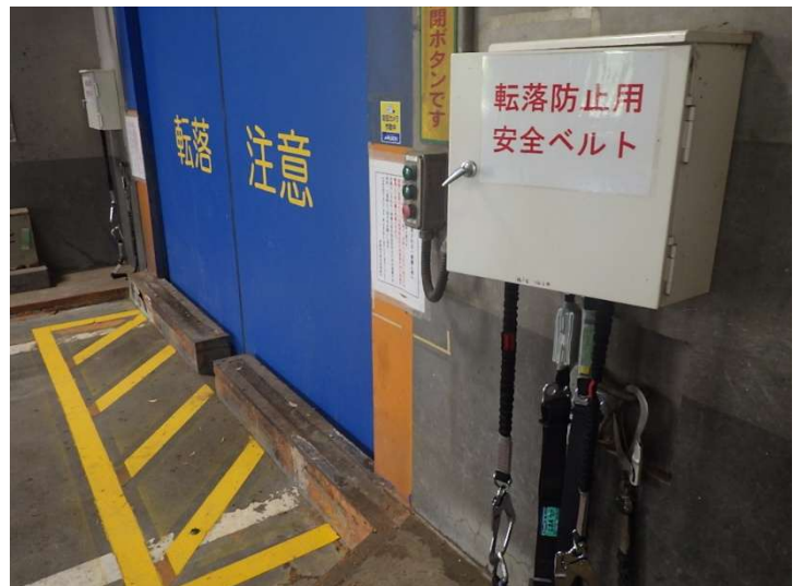
横壁に据え付けられている安全ベルト
